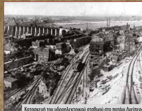
Κατασκευή του υδροηλεκτρικού σταθμού στο ποτάμι Δνείπερος, στην πόλη Ζαπορίζια το 1929. Η πρώτη διανομή της ηλεκτρικής ενέργειας ξεκίνησε το 1932, ενώ η κατασκευή ολοκληρώθηκε πλήρως το 1939. Ο σταθμός έγινε ένα από τα σύμβολα του κομμουνιστικού εκσυγχρονισμού και της εκβιομηχάνισης.
